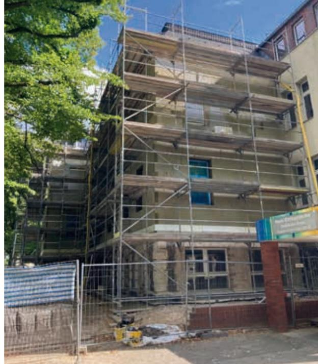
Mit dem Ziel, zukünftig weniger fossile Energieträger zu benötigen, wurde Haus Conradshöhe entsprechend gedämmt und saniert.
